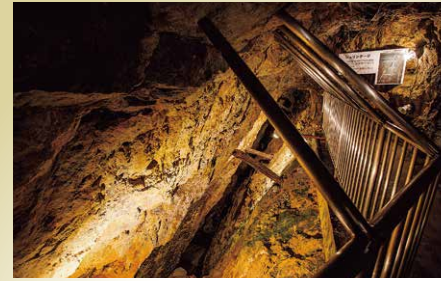
シュリンケージ採掘跡 下部の坑道から採掘して掘った鉱石を、全部下に抜きとった跡です。
